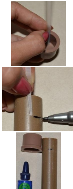
Fig. 11. Determinando a profundidade da conexão e marcando-a sobre a ponta do cano.
